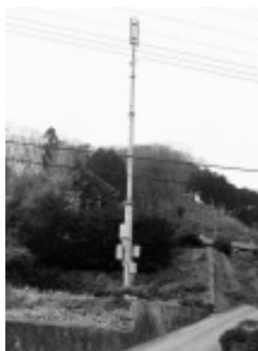
▲千田地区に建設された鉄塔
