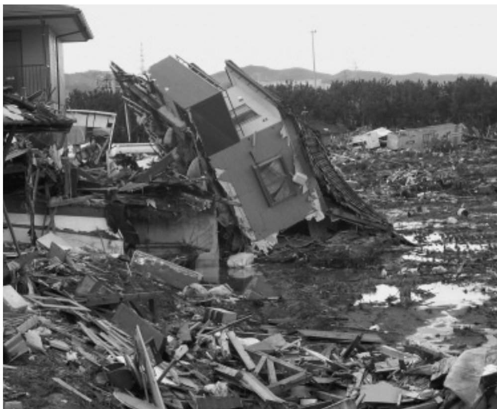
▲福島県相馬市の津波被害
