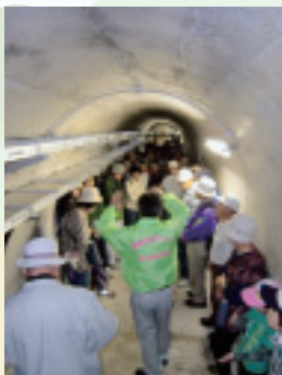
▲堤体内部地下50mにある監査廊 (ダムの安全を確かめる通路)
