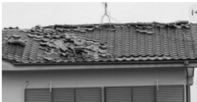
屋根瓦破損
