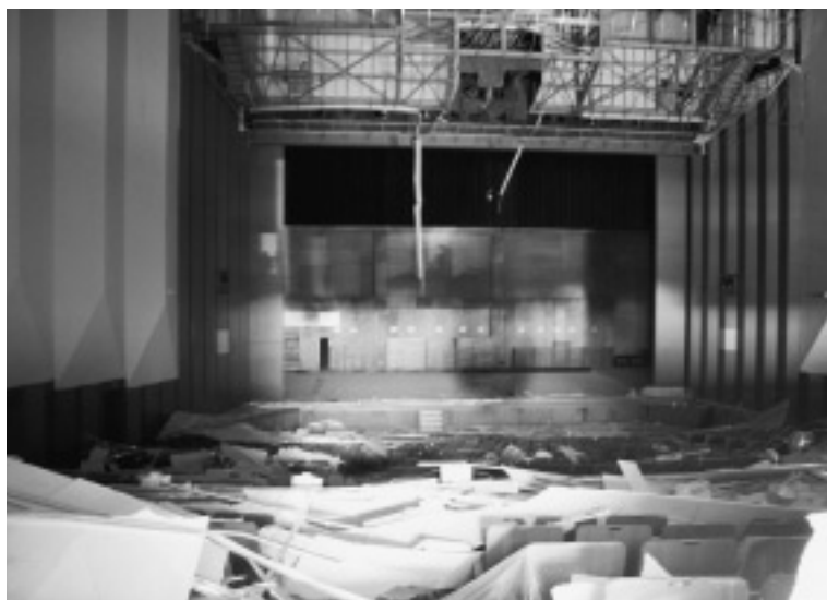
市文化センター大ホールの天井が崩落
