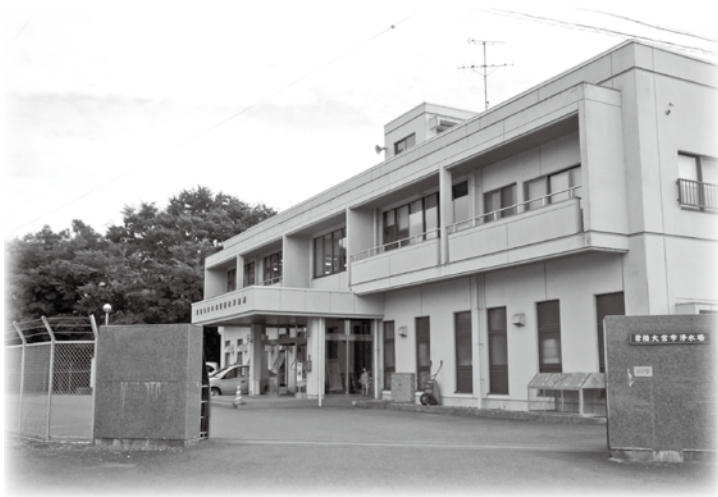
▲常陸大宮市水道管理事務所
