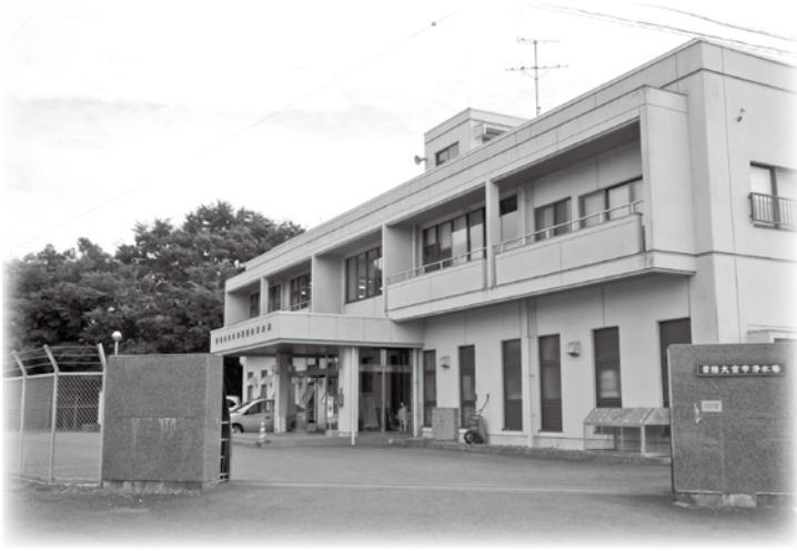
▲常陸大宮市水道管理事務所
