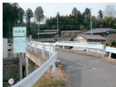
▲南側からみた嘆願橋。写真奥は中ノ城。奥右手が御城（主郭）。
