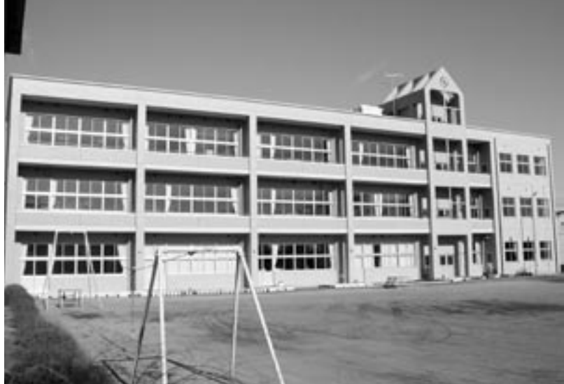
▲完成した村田小学校校舎
