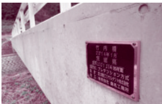
▲農道大岩線の小舟川に架かる竹内橋
