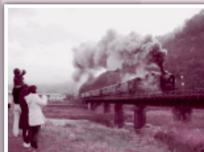
▲常陸大子駅手前の陸橋
