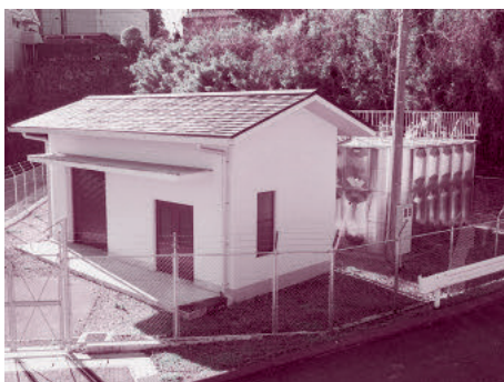
▲根古屋増圧ポンプ場
