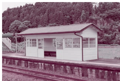
◀山方宿駅ホーム待合室 建築年を示す「T 11」が残る
