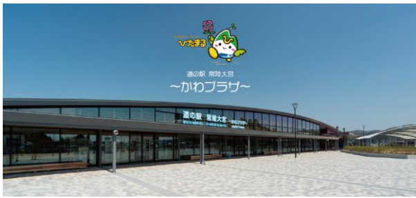
【かわプラザ（道の駅 常陸大宮）】
