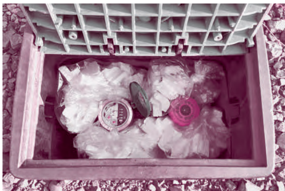
▲メーターボックス内を発泡スチロールや布などで保温します。
