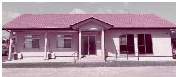
▲新設された栄町コミュニティセンター
