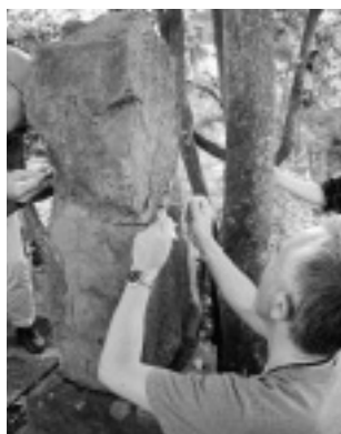
▲接着・充てん作業の様子
