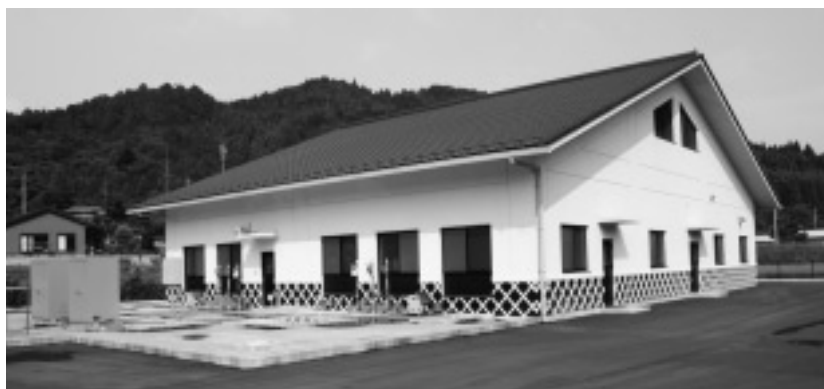
▲平成22年に供用開始した美和中部地区農業排水処理施設
