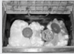
▲量水器ボックス内に隙間無く詰める。
