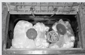
▲量水器ボックス内に隙間無く詰める。
