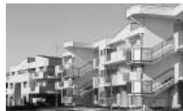
町営桜の丘住宅建設
