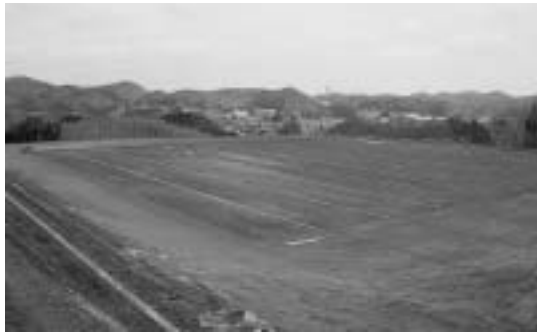
建設中の総合運動公園
