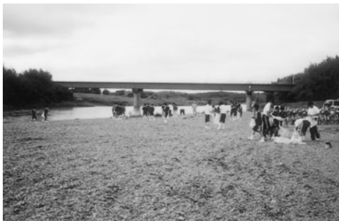
▲富岡橋周辺での作業の様子
