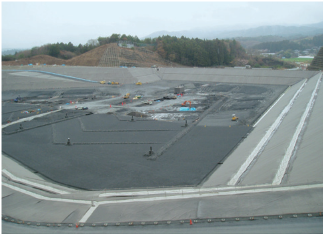
平成17年8月竣工に向け建設中のエコフロンティアかさま (最終処分場)
