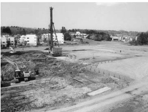
▲（仮称）県北西部地域中核病院の建設現場 — 4月上旬 —
