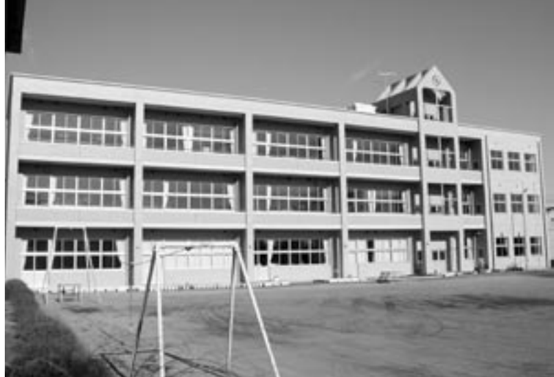
▲完成した村田小学校校舎
