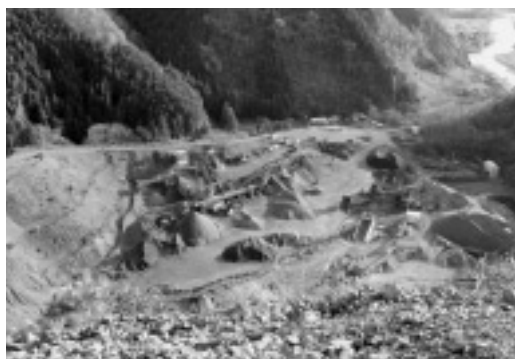
▲丸山物産（株）西ノ内採石場の眺望（採石場頂上から）
