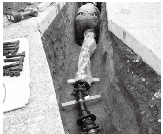
老朽管の更新工事
