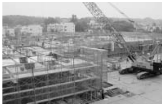
建設中の常陸大宮済生会病院
