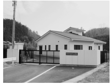
農業集落排水施設
