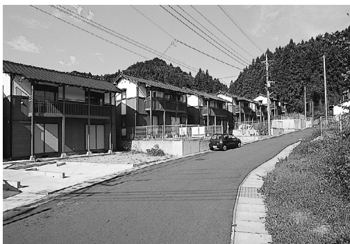
過疎地域の住宅対策（市営住宅）
