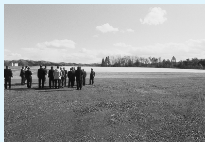
整備中の緒川総合運動公園
