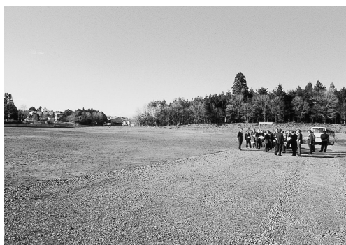
病院建設用地
