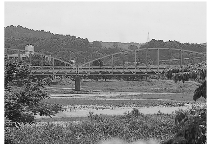
景観の美しい那珂川大橋周辺
