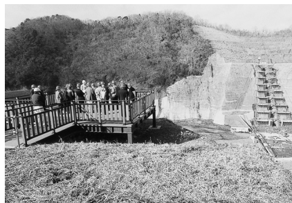
御前山ダム建設地
