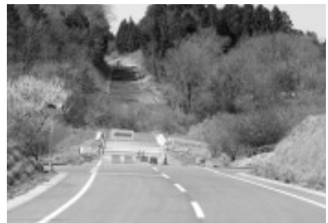
野上地区内の未整備道路
