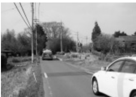
県道長沢水戸線（東野地内）
