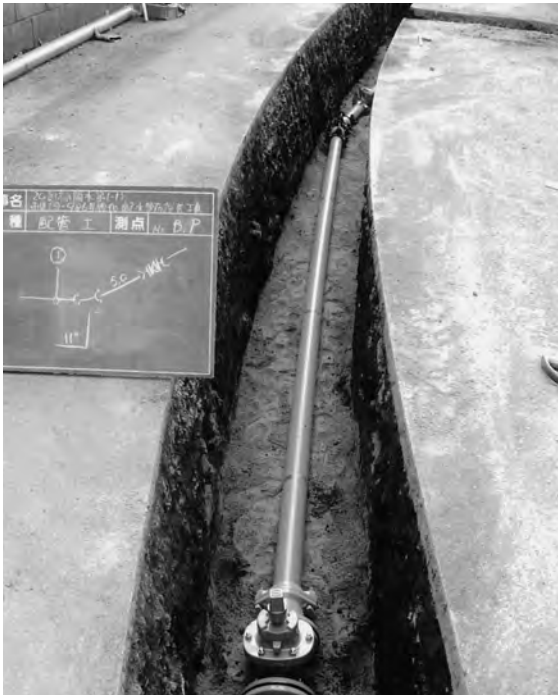
配水管布設替工事
