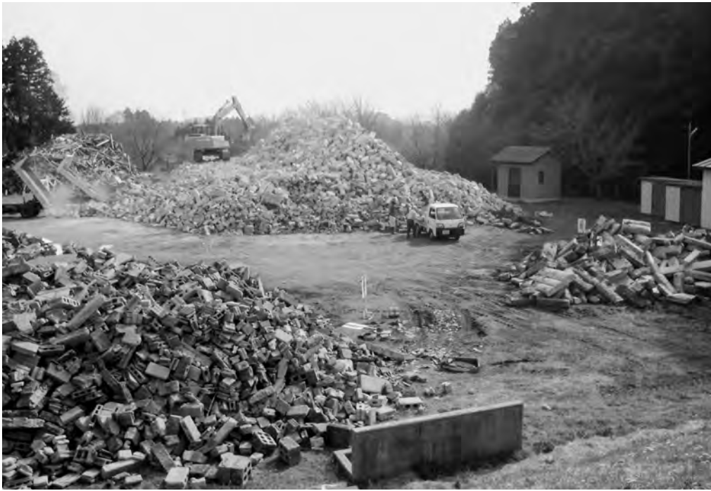
震災廃棄物仮置場
