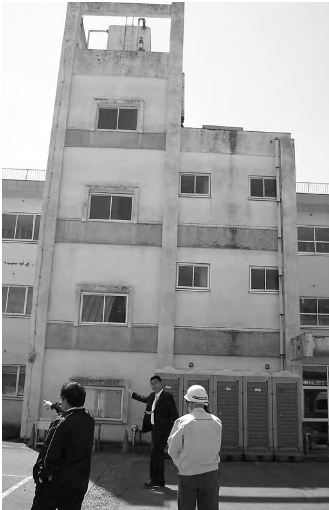
被災した大宮中学校
