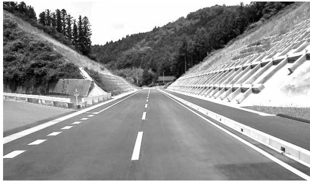
県道下松沢上小瀬線の改良道路
