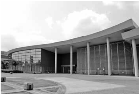
復旧工事中の文化センター
