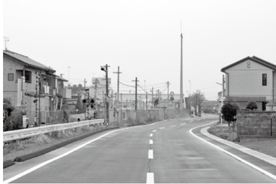
常陸大宮駅西側市道改良舗装
