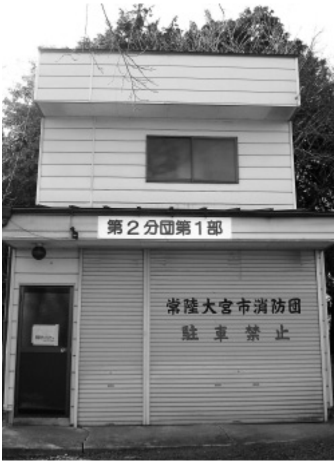
機械器具置場と詰所（八田地区）
