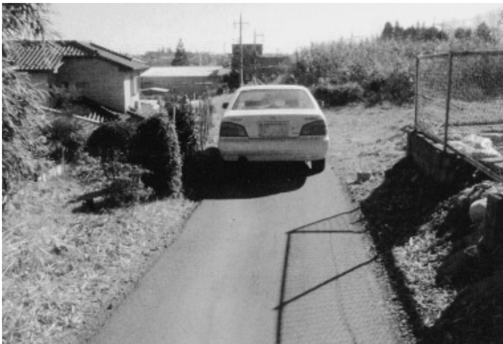
請願中の道幅の狭い市道
