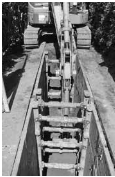
管渠布設工事
