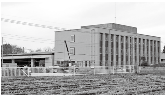
建設中の消防庁舎
