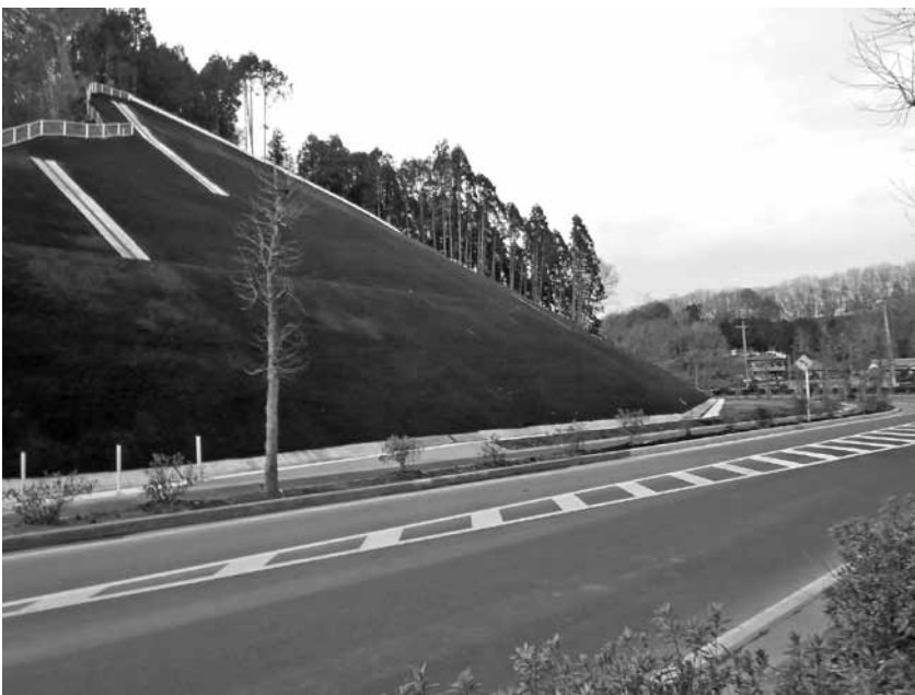
復旧した市道4389号線（小野トンネル付近）
