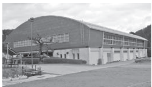
改築工事を行う美和小学校屋内運動場
