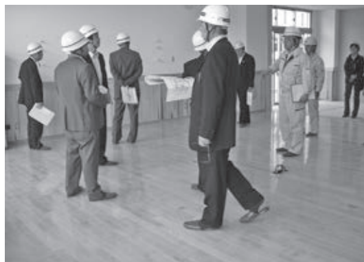
完成間近の普通教室 現地踏査
