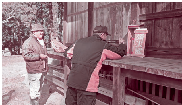
▲ 消防設備点検
