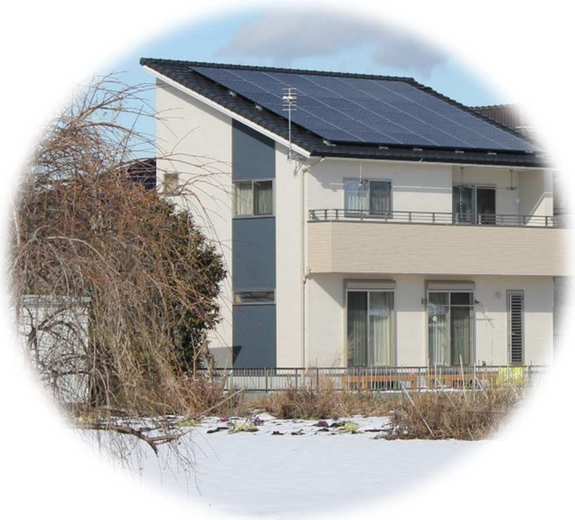
住宅用太陽光発電システム
