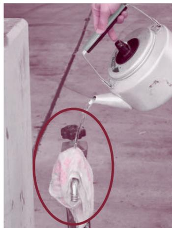
凍った部分にタオルや布をかぶせ、必ず「ぬるま湯」をゆっくりとかけて溶かしてください。熱湯をかけると、水道管が破裂する恐れがあります。必ず、ぬるま湯で溶かしてください。※蛇口を開けても水が出ない時は、蛇口を開けたままにせず必ず閉めてください。
