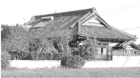
市内の空き家
