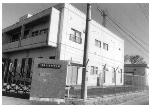
常陸大宮市浄水場
