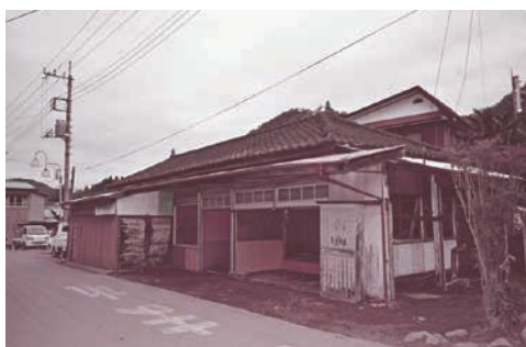
▲被災した旧下小川支所の建物(盛金地区)
