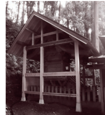
▲吉田八幡神社（改修工事終了後）
