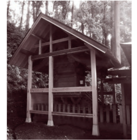
▲吉田八幡神社（改修工事終了後）
