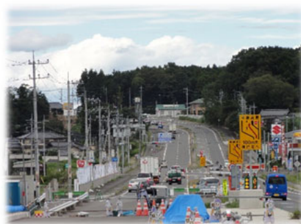
都市計画道路 3・3・9 下村田泉線 (国道 118 号)
