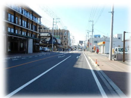
都市計画道路 3・4・4 宮中清水線 (主要地方道常陸大宮御前山線)
