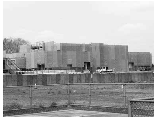
建設が進む学校給食センター
