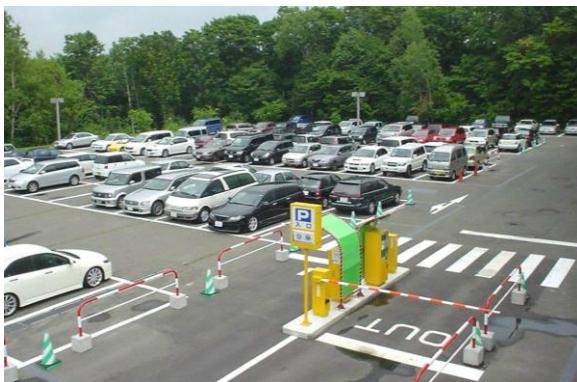
事例：札幌市エレクトロニクスセンター
