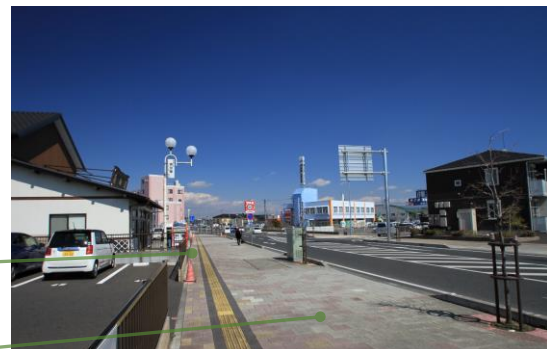
事例：水戸市都市計画道路内原駅北線
