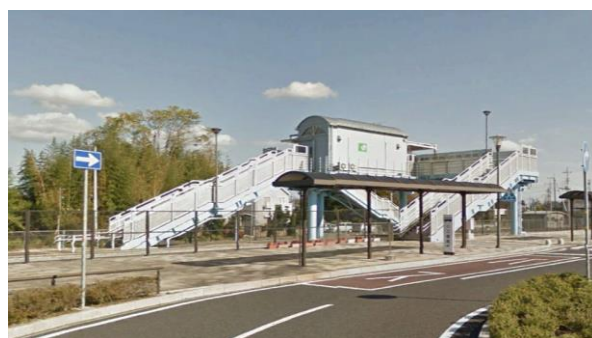
事例：JR 水郡線 瓜連駅（橋上駅） （出典：Google Earth）
