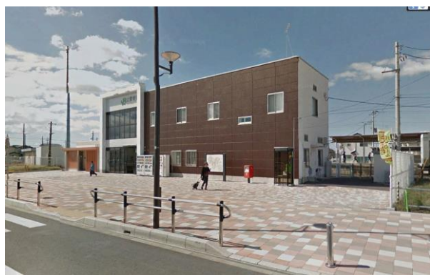
事例：JR 水郡線 上菅谷駅（地上駅） （出典：Google Earth）
