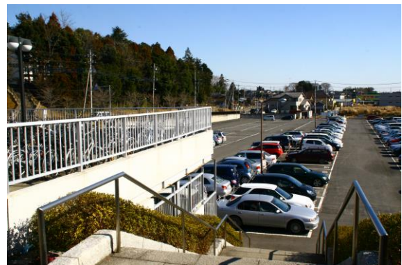
事例：石岡駅東市営駐車場
