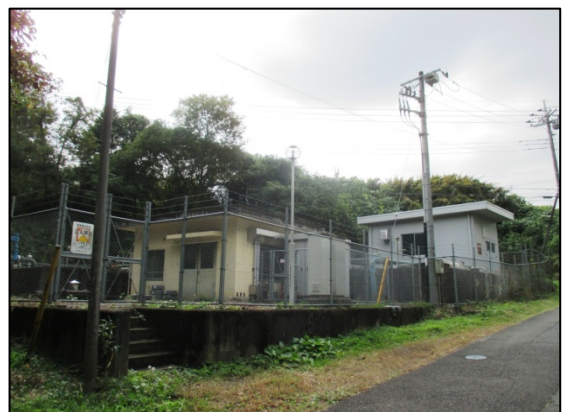
鷹巣増圧ポンプ場
