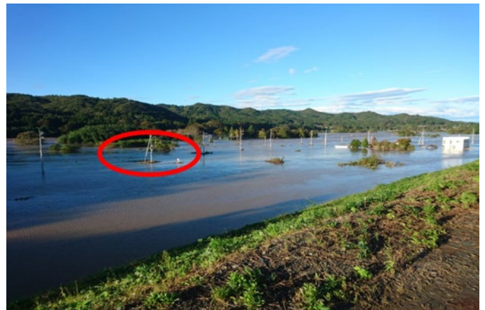
御前山地域北部取水場冠水
