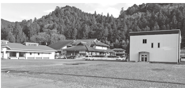
中央空き地に駐車場を整備 (左は美和診療所、右が美和支所、奥が工芸ふれあいセンター)
