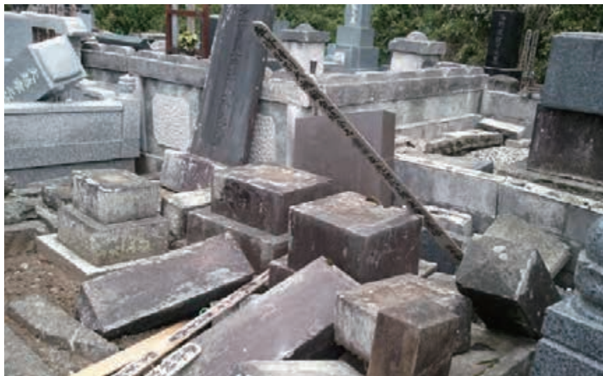
東日本大震災による墓地の被害（下町）
